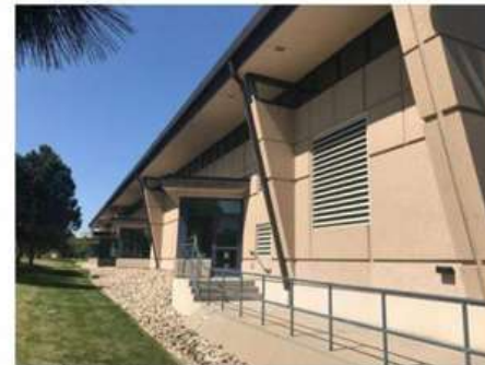
E. Non-ADA Exit
