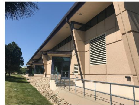
E. Non-ADA Exit
